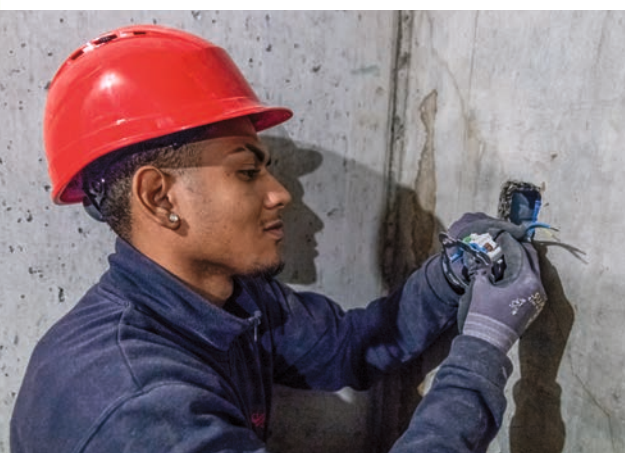
✓ Luis Miguel Bianchi installiert eine Steckdose in die Wand. Das Loch in der Wand hat er zuvor selbst aufgeschlagen.
