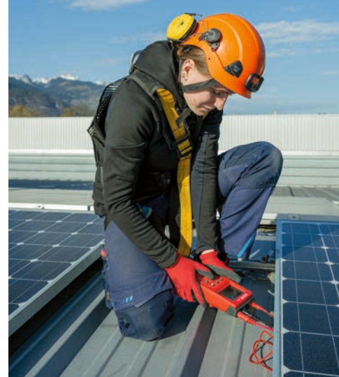
^ Cassidy Perrin prüft, ob die Solarpanels richtig angeschlossen sind und der Strom fliesst.
